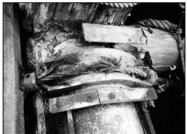
Bild 33: Sattel einer Brücke in einem Vergnügungspark. Stehendes, z. B. auf Sätteln festgehaltenes, Wasser erzeugt starke Korrosion.
