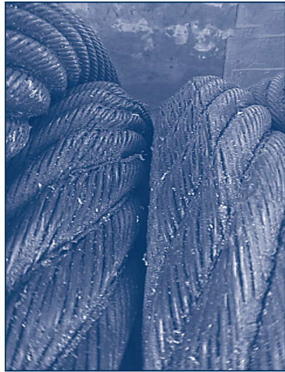
Bild 26: Die Folgen des "Einschneidens"
